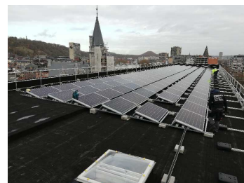
Installation des panneaux du XX août
